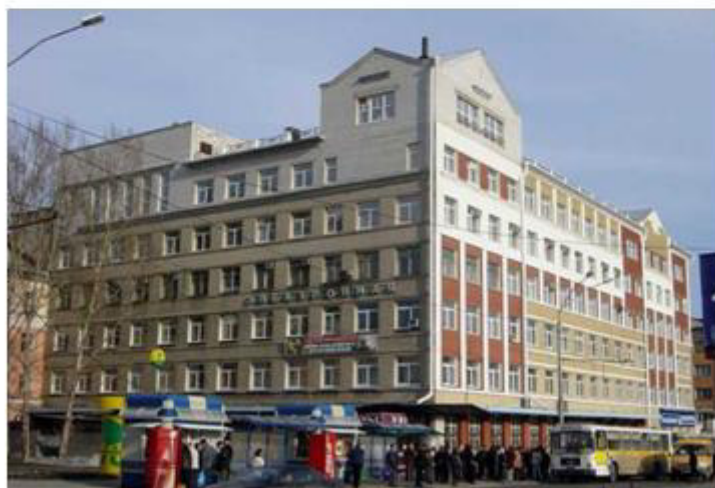
То же здание после реконструкции, проведенной в 2003-2004 гг.. Надстроен шестой этаж, угловая башенка. Улучшено внешнее оформление.
