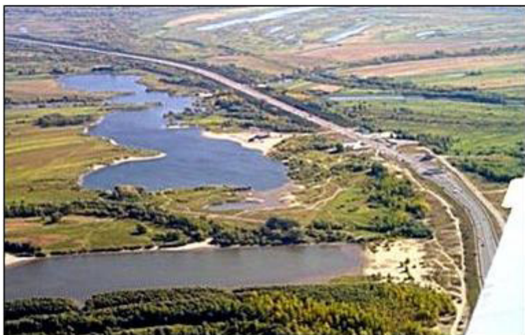
Подъездная дорога к мосту с Новоалтайской стороны. Проезд по мосту штатный.
