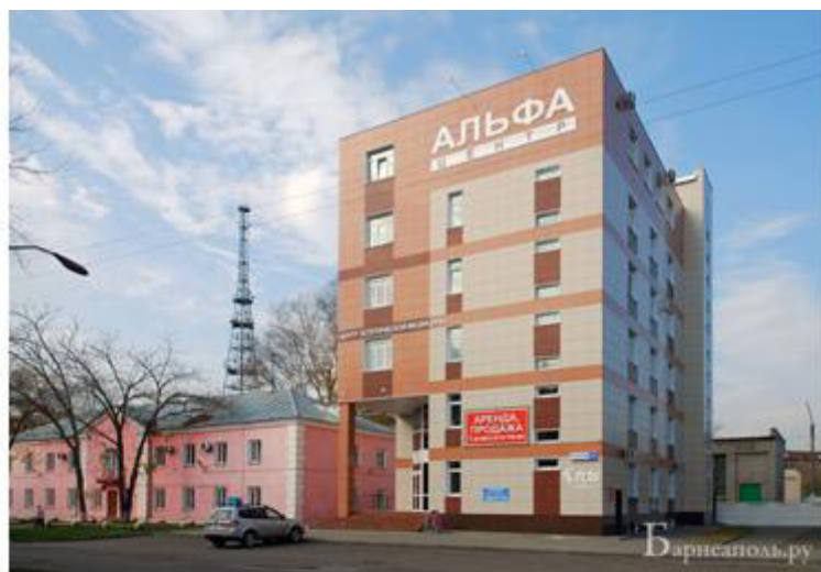
6-этажное административное здание Альфа центра, построенное в 2009 г. (ул. Союза Республик, 36Б). Фото из сайта http://barneapool.ru
