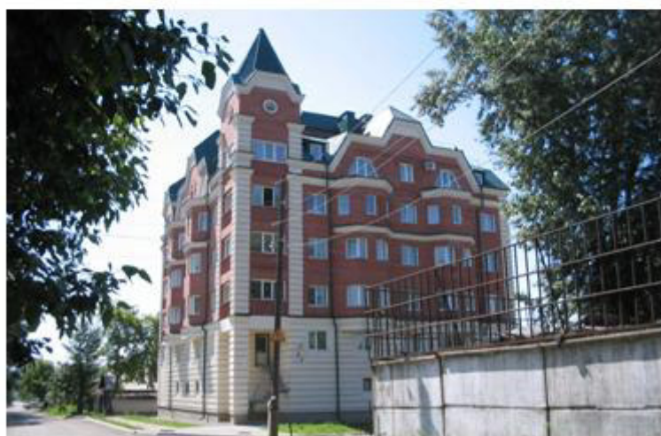
6-этажный жилой дом по ул. Короленко, 113 / пер. Радищева, 29. Постройка 2006 г. Фото автора, 2007 г..
