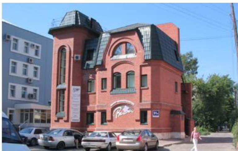
Здание косметологического центра «Виола» по ул. Деповская, 21-а Фото автора.
