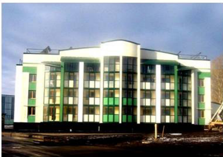
«Дом с подогревом» - новое в домостроении Барнаула. Это первый в крае энергоэффективный 19-и квартирный дом, оборудованный 22 солнечными батареями, увязанными в единую систему с подземной геотермальной установкой. Ожидаемая годовая экономия 241 тыс. киловатт/часов электроэнергии. Гл. проектировщик А.Суртаев. Дом введен в эксплуатацию в 2010 г ул.Смирнова, 69. Фото автора, 2010 г.
