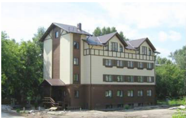
Административное здание, постройки 2008 г. (ул. Северо-Западная, 23а/2. Фото автора, 2008 г.)
