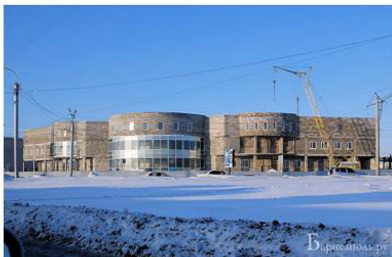
Строящееся здание торгового центра «Автолидер» по ул. Попова, 214. Фото 2010 г. из сайта http://barneapol.ru
