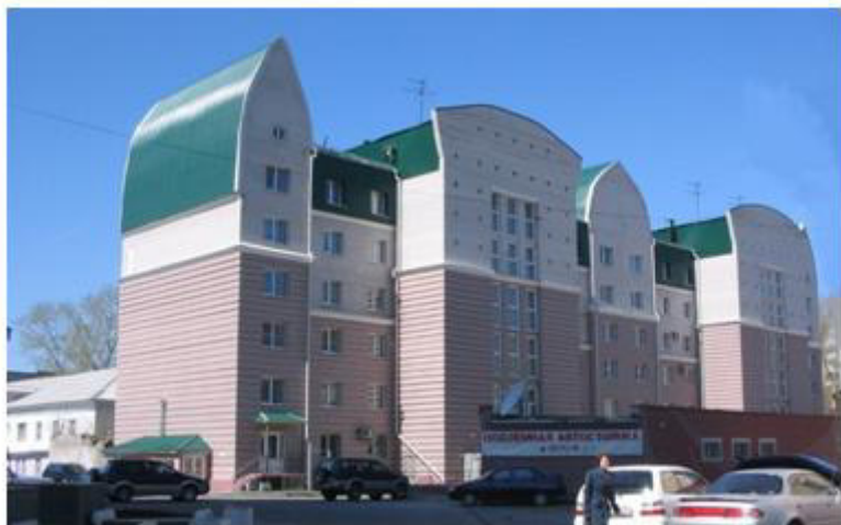
6-этажный жилой дом по пр. Ленина, 127-а. Построен в 2005 г. Архитектор А.Ф.Деринг. Фото автора, 2006 г.
