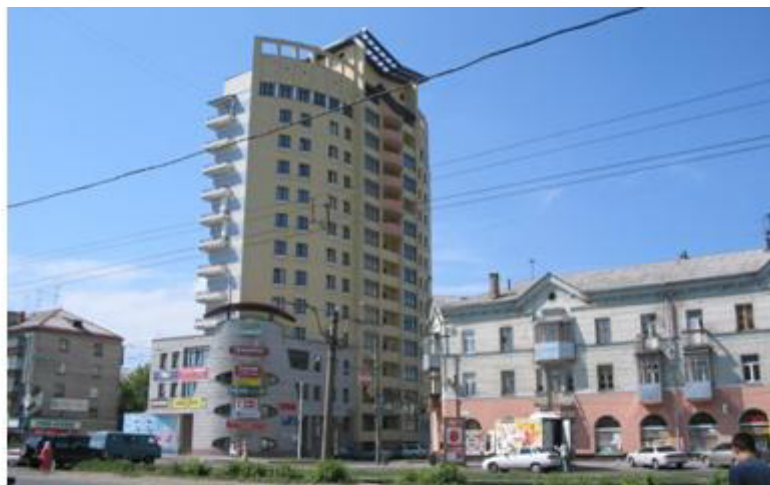
13-этажный жилой дом по пр. Ленина, 103-а, постройки 2004 г. Архитектор В.Г.Ли Джи-Дзун. На первом этаже торговый дом Фламенко, АлтайЭнергобанк, туристическая фирма Круиз, страховые компании и др. Фото автора. 2007 г.
