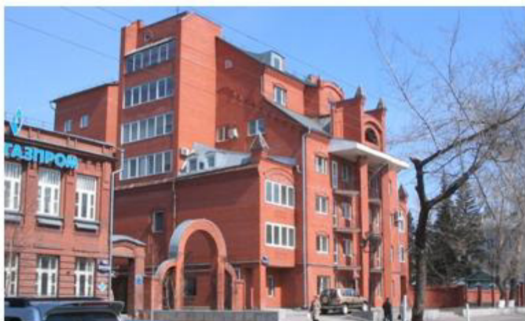
7-этажный жилой дом с административными помещениями по ул. Никитина, 88. Построен в 1995 г. Фото автора, 2006 г.
