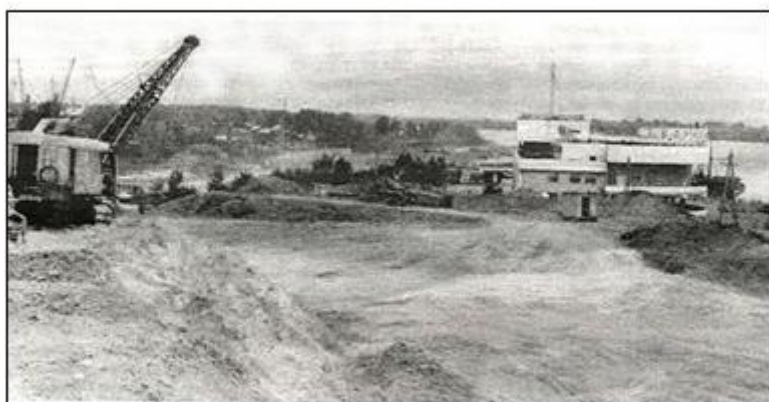
Сооружение транспортной развязки на пр. Ленина у речного вокзала. Фото: начало 1990-х гг.
