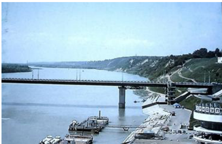
Река Обь у Барнаула и новый автомобильный мост.
