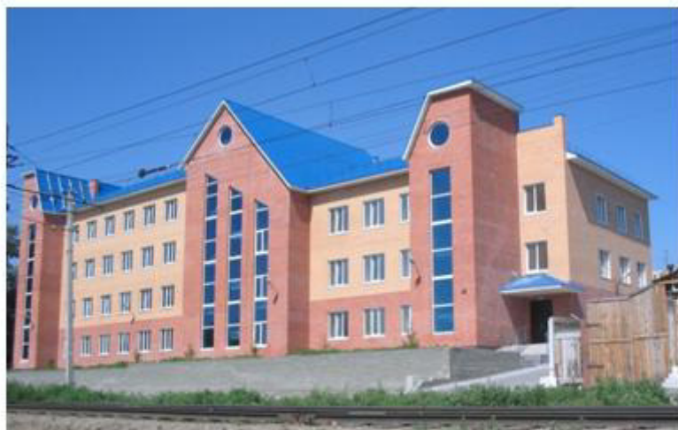
Административное здание по ул. Анатолия, 134. Здесь находится Алтайский краевой центр по гидрометеорологии и офисы ряда организаций. Фото автора.
