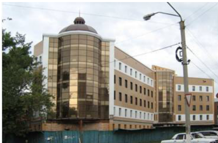
6-этажное административное здание бизнес-центра «Форум». Площадь здания 7200 кв.м. Постройка 2009 г. (ул. М.Горького, 29 / ул. Гоголя, 36) Фото автора, 2009 г.
