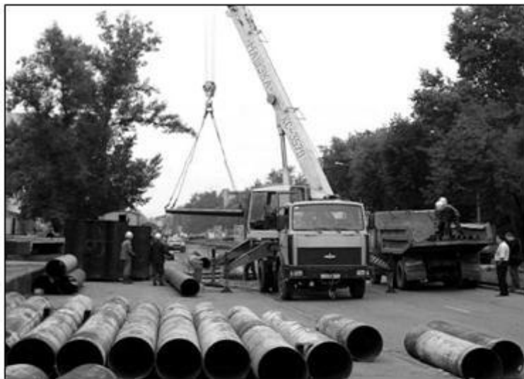
Летние заботы городской администрации - подготовка к предстоящей зиме: завоз топлива, ремонт котельных и теплотрасс. На снимках перекладка и ремонт теплотрасс в городе. 2008 г.
