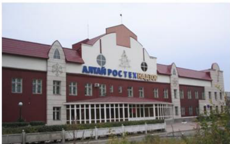
Административное здание Алтайского межрегионального управления Ростехнадзора после реконструкции. (пр. Калинина, 65) Фото автора, 2007 г.
