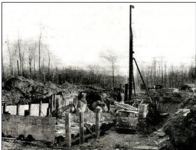
Возведение мостовой опоры на правом берегу Оби. Фото: март 1990 г.
