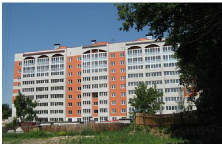
Жилой 9-этажный дом по ул. Северо-Западная, 29-а, построен в 2008 г. Фото автора, 2008 г.
