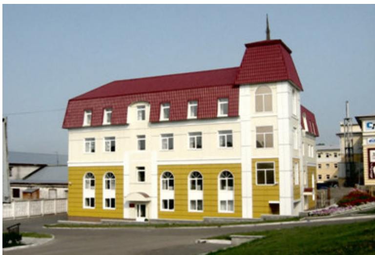
Административное 3-этажное здание по пр. Красноармейский, 13. Постройка 2008 г. Фото автора, 2010 г.
