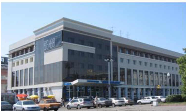
Проведенная реконструкция придала зданию гостиницы современный внешний вид. Фото автора.
