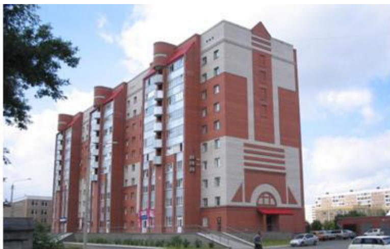
10-этажный жилой дом по ул. Шумакова, 16. Построен в 2004 г. На первом этаже салон красоты «Багира», магазин М-Рекордс, Инчанс-центр. Фото автора.
