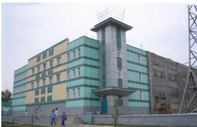
На этом снимке видно, как можно изменить вид здания при реконструкции. Левая сторона здания - после реконструкции, правая, темная - еще ею не подвергнута. (ул. Сухова, 68-а) Фото автора, 2006 г.
