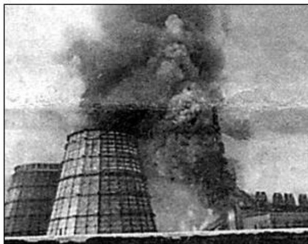
Пожар на Барнаульской ТЭЦ-3 19 января 2010 г. Сгорели два транспортера подачи угля. Фото О.Кунаковского.
