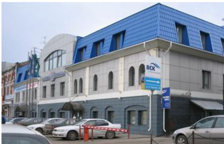
Торговое здание «Компьютер-трейд» после реконструкции. В таком дизайнерском исполнении оно плохо вписывается к рядом стоящим старинным зданиям. (ул. Толстого, 22)
