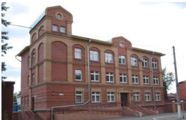
Административное здание по ул. Короленко, 65. Здесь находится Специализированная похоронная служба г. Барнаула. Фото автора, 2006 г.
