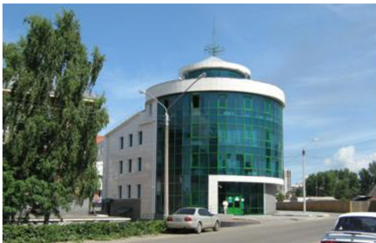
Четырехэтажное административное здание Алтайсбербанка по Обскому бульвару, 30. Постройка 2007 г. Фото автора, 2008 г.
