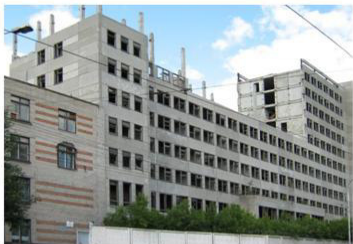
Это не новостройка. Наоборот. Уже 5 лет как это 11-и-этажное здание разбирают по строительным элементам. (пр. Космонавтов, 8). Фото автора, 2008 г..
