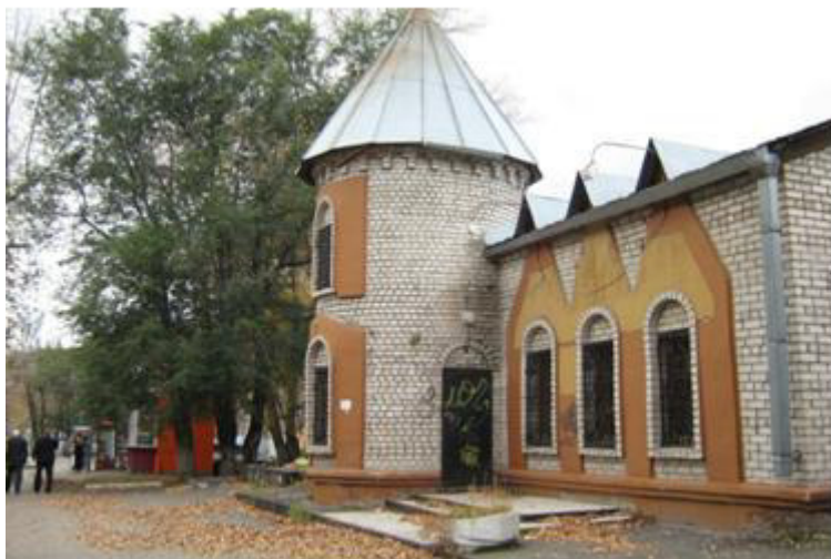
Торговое здание по ул. Путиловская, 4а. Фото автора. 2009 г.
