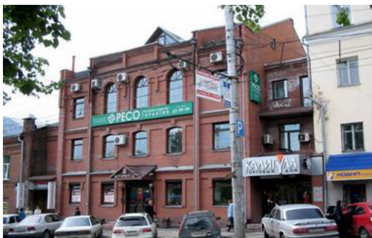
Административное здание, построенное в старом стиле, хорошо вписалось с рядом стоящим домом постройки начала XX века. Архитектор Л.В.Гладких. (пр. Ленина, 21-а). Фото автора, 2007 г.
