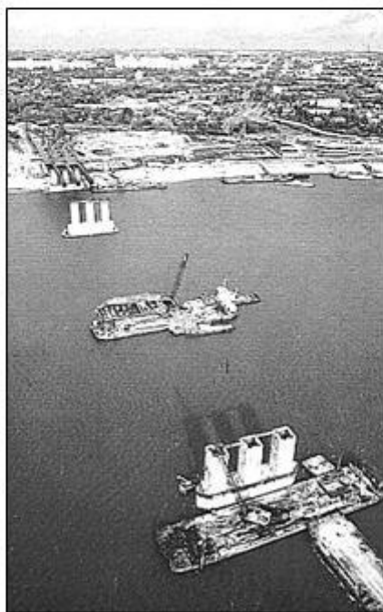
В 1989 году начато строительство первой опоры Обского моста у Речного вокзала. Последняя опора построена в 1994 году.
