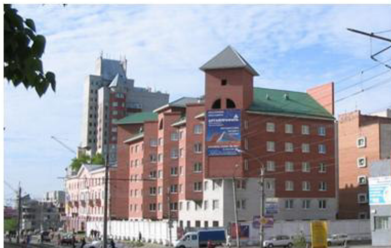
Строящийся 6-этажный жилой дом по пр. Красноармейскому, 101 / ул. Крупской, 91. Строительство закончено в 2009 г. Фото автора, 2006 г.
