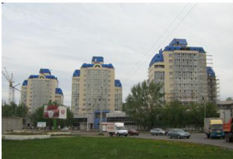
Строительство трех 12-и-этажных жилых домов по улице А.Петрова, 196, 196-а и 198. Строительство закончено в 2008 г. Фото автора, 2008 г.
