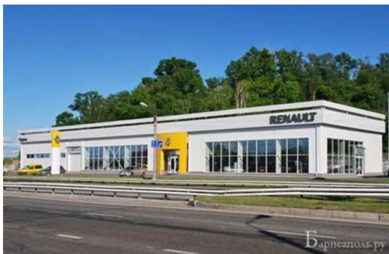
Авто-центр «Рена-Моторс», построенный в 2007 г. Площадь 1 500 кв. м. (ул. Мамонтова, 25) Фото из сайта http://barneapol.ru
